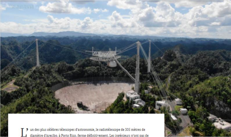
**L'**un des plus célèbres télescopes d'astronomie, le radiotélescope de 305 mètres de diamètre d'Arecibo, à Porto Rico, ferme définitivement. Les ingénieurs n'ont pas de solution sûre pour le réparer après la rupture soudaine et catastrophique de deux câbles soutenant la structure, l'un en août et l'autre début novembre.
